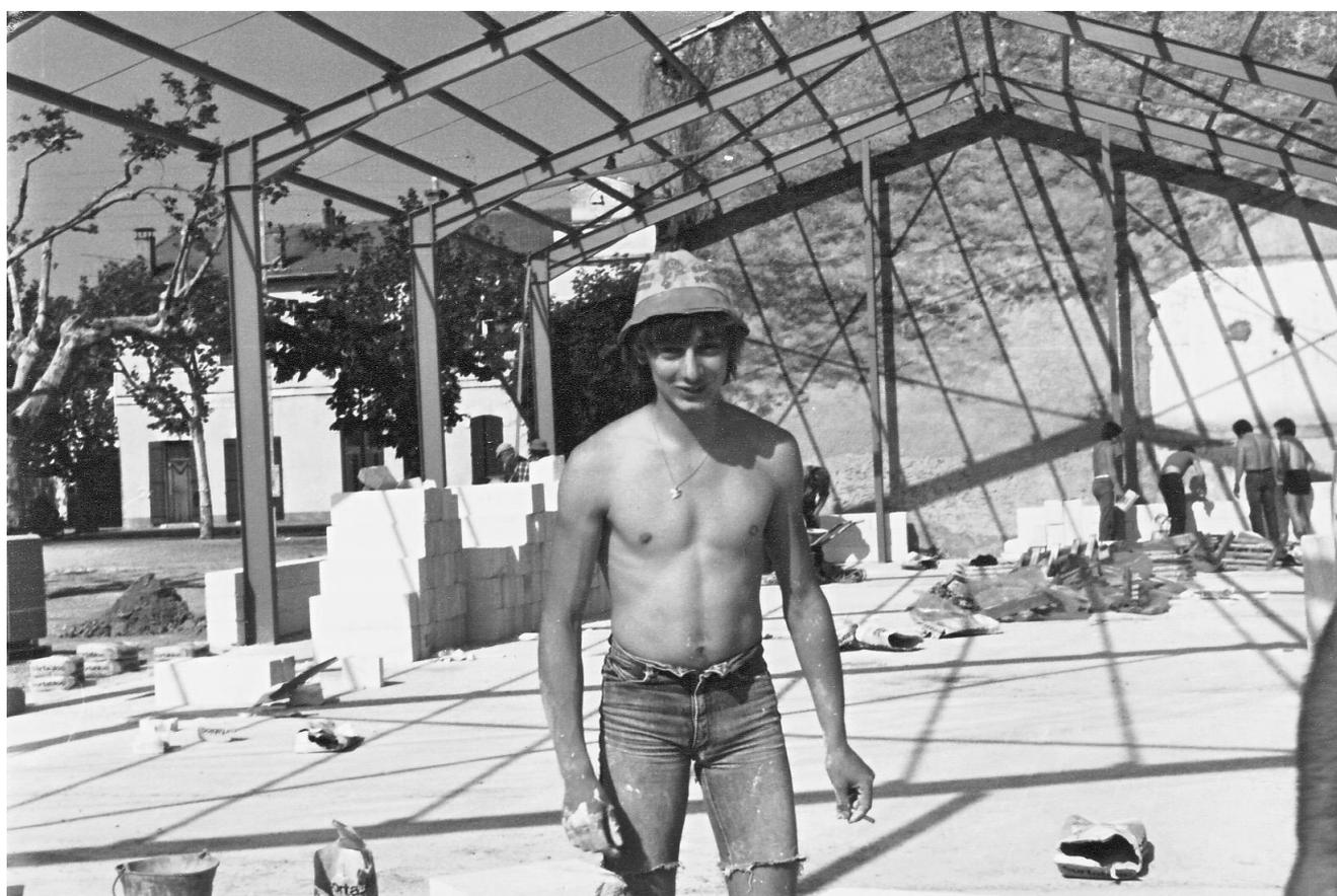
***Patrice DURAND prépare la colle nécessaire à l'assemblage des blocs de Siporex.***
